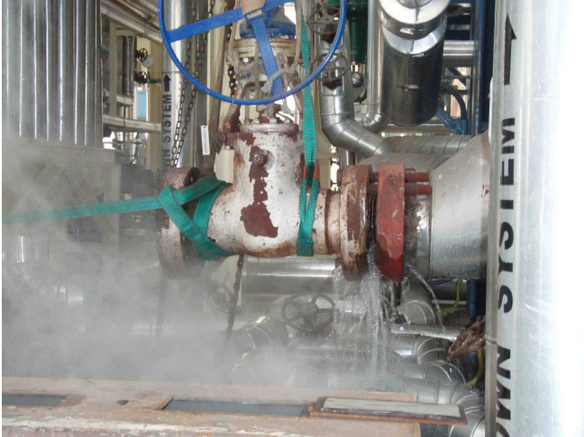
Desmontaje de la válvula de 6" (1500 PSI)
